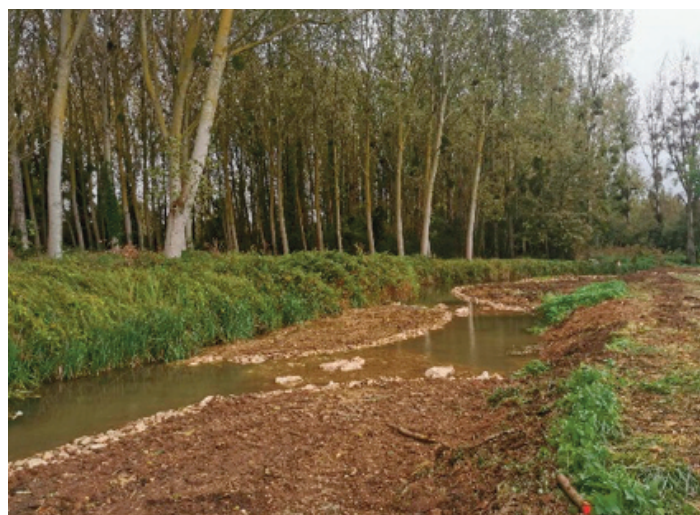
Après travaux : oxygénés, radiers, fosses, habitats
